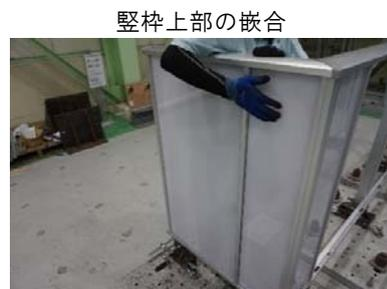
3) 嵌合された堅枠上部の左右に堅押縁 (L=50) を嵌合し、抵抗がつくまで下へスライドします。
