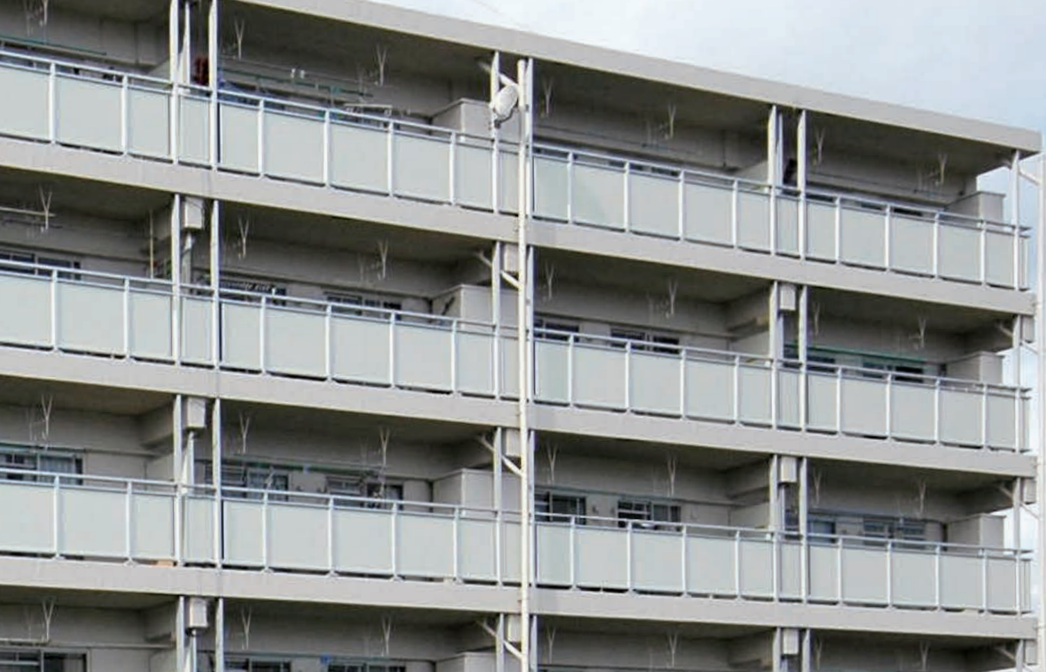
After ベースプレート工法
